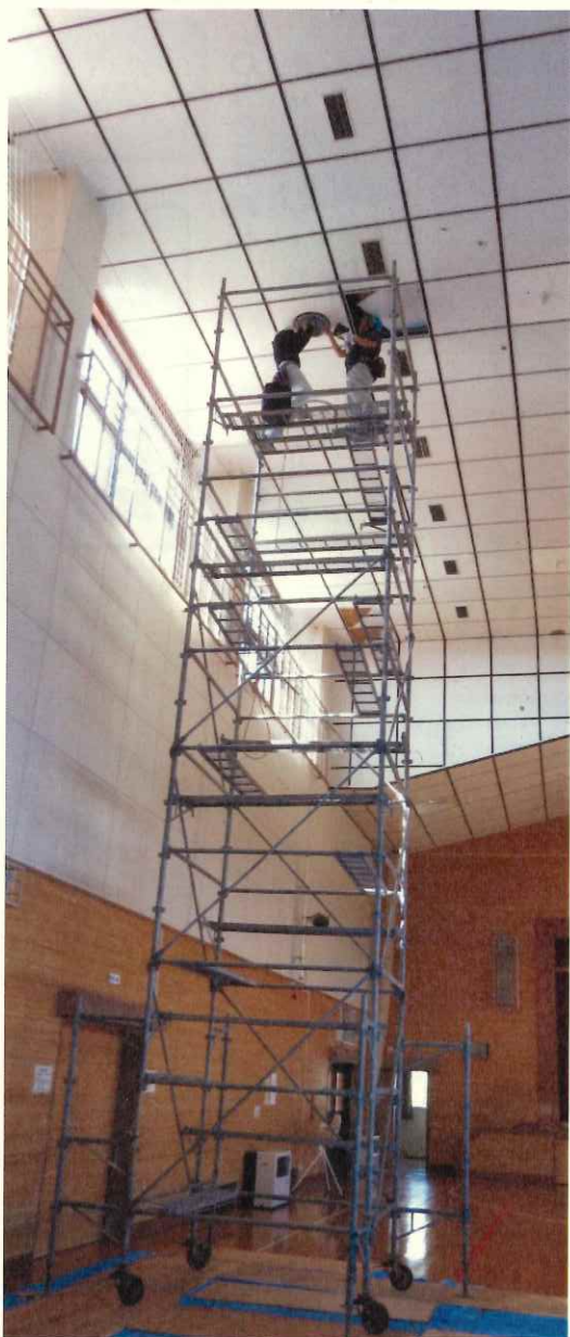
足場を組上げての作業でした
